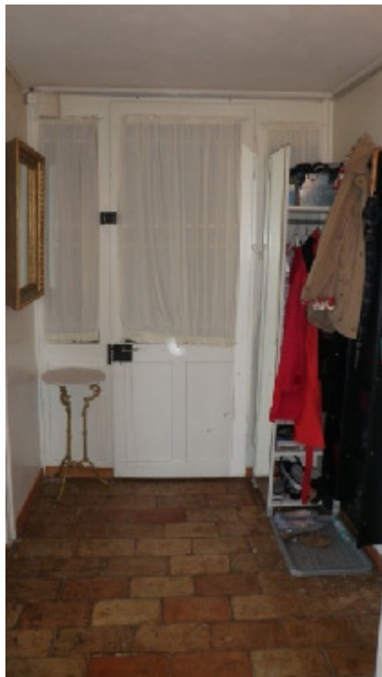
Klinker im Gang, Weggengasse 6, 8001 Zürich
